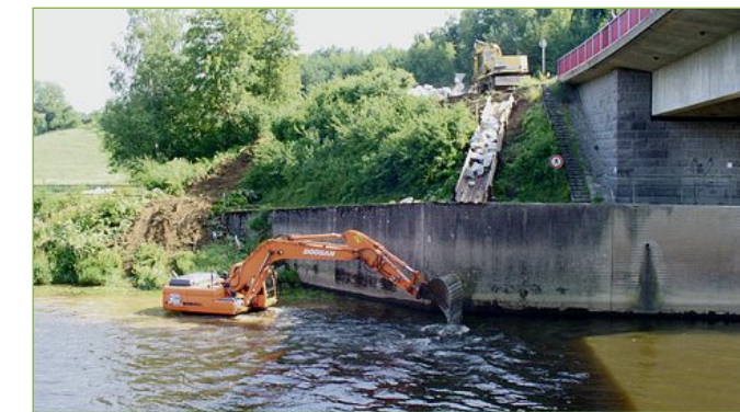
Schütten der Buhne.
