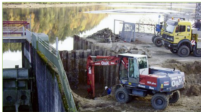
Aushub der Raugerinntrasse im Schutz der Spundwand.
