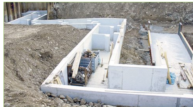
Bau des Schlitzpasses im Schutze der Spundwandsicherung am Einstieg.
